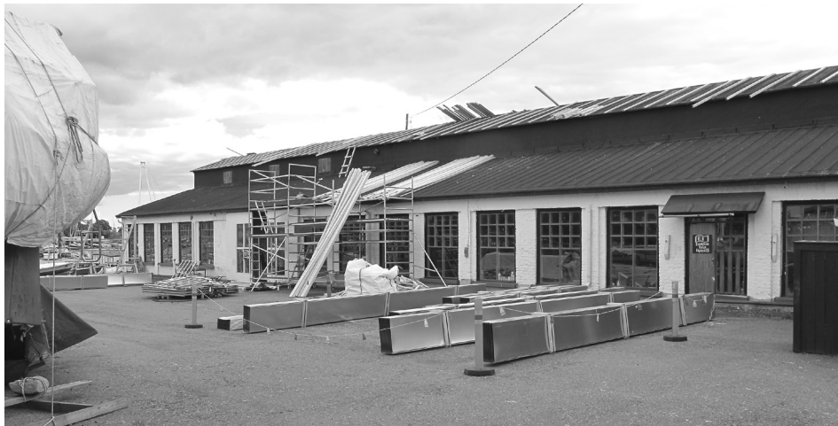
Työt ovat alkaneet ja kattoratsastajalla on uutta aluskoolausta ja pihalla peltivuotia odottamassa asennusta. Puutavaraa meni kattoon kilometrikaupalla.
