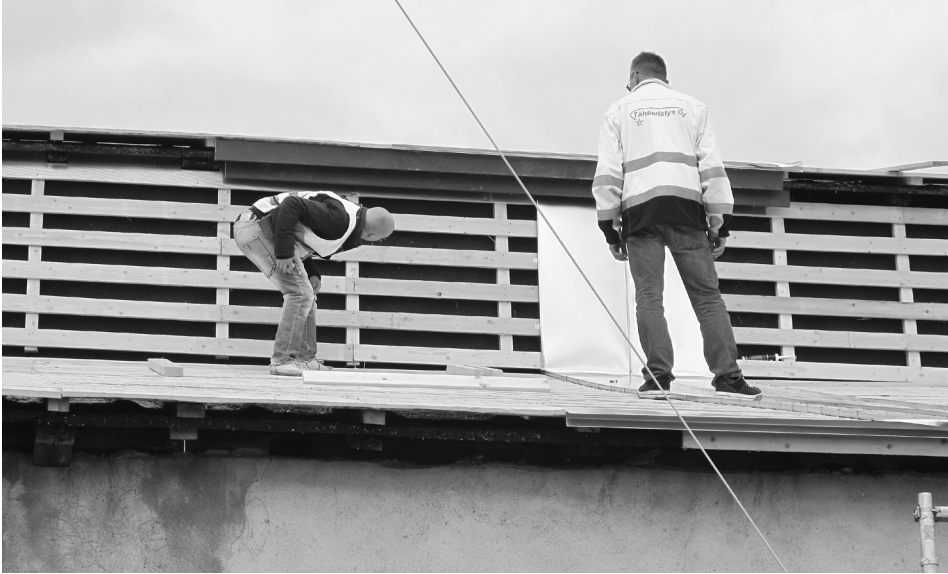
Vanha huopa jätettiin uuden katon alle aluskatteeksi, sen päälle tehtiin aluskoolaus ja sen päälle laudoitus, johon uusi peltikatto kiinnitettiin. Vanhat räystäslaudat uusittiin.
