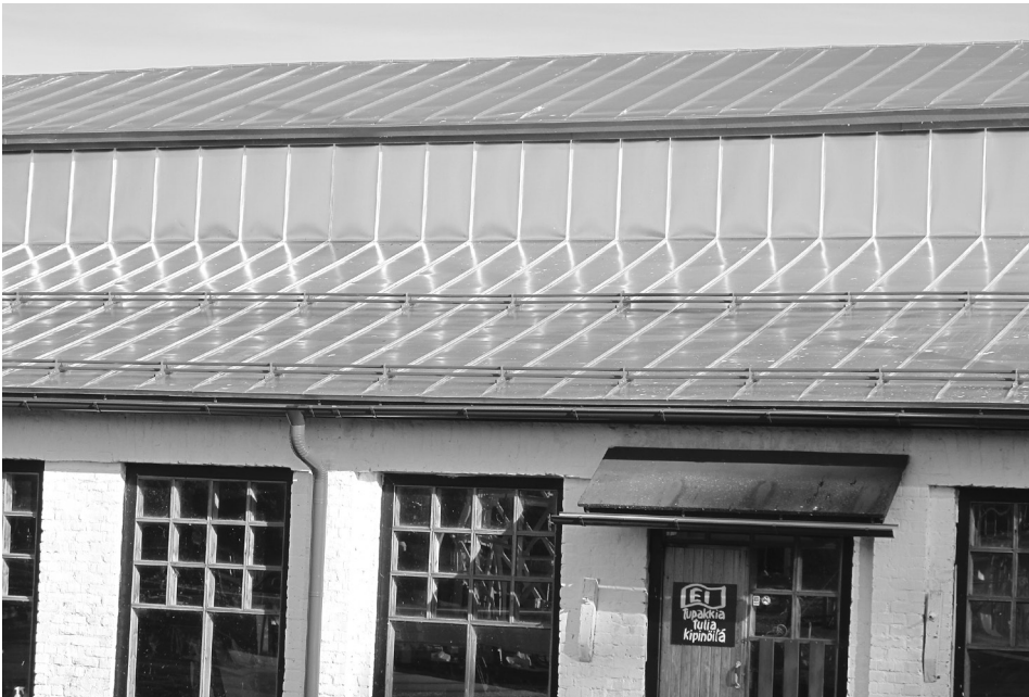
Uusi kattopelti kiiltelee elokuisessa iltapäivän auringossa. Katto alkaa olla maadoituskaapeleita vaille valmis.
